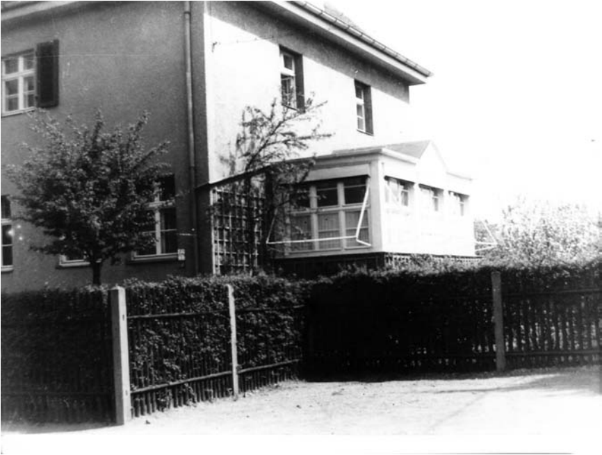
The house at Bozener Weg 14
