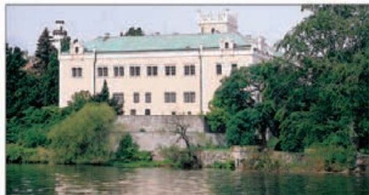
The palace in Klášterec nad Ohří
