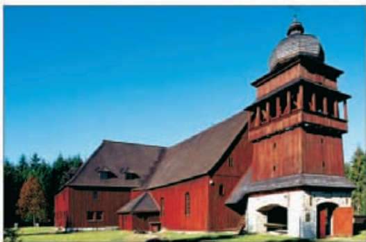
Traditional timber church, Svätý Kríž
