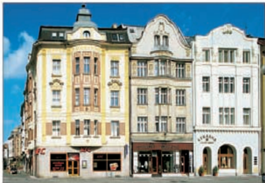
Houses in Poštovna, near Masarykovo náměstí in Ostrava
