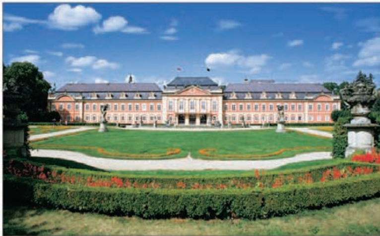
The formal Baroque façade of Dobříš Palace
