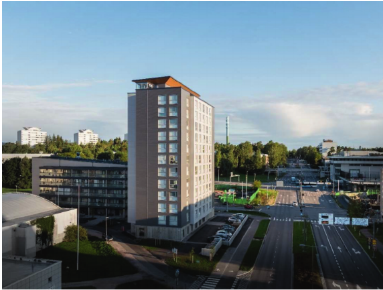
Figure 4. HOAS Tuuliniitty (photo by Miika Ullakko, courtesy of Arkkitehti toimisto Jukka Turtiainen/Arkkitehti palvelu Oy).
